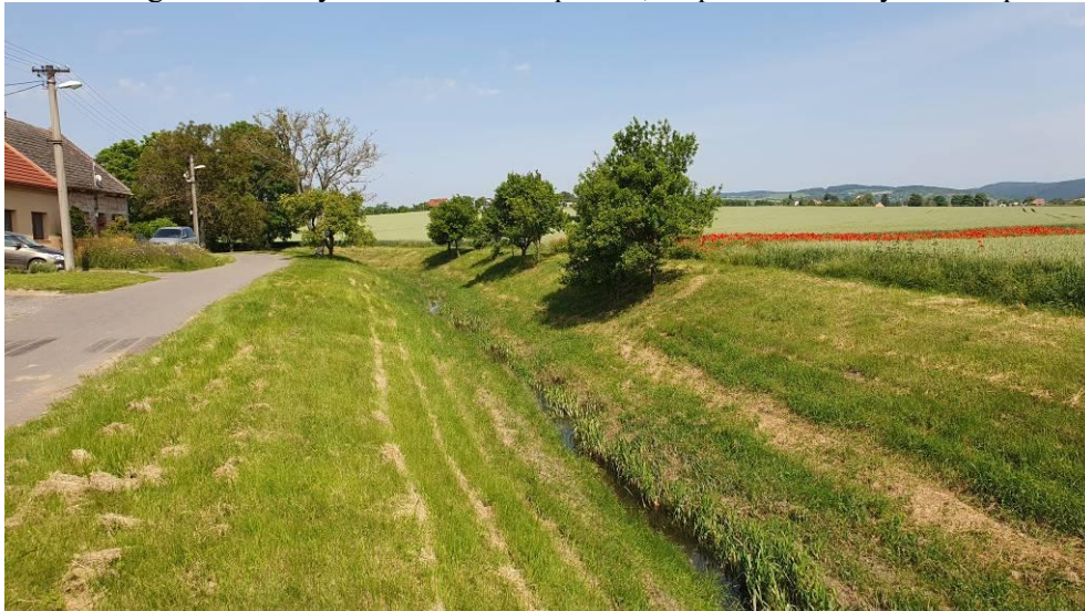
Foto 8: Regulované koryto Jankovického potoka, na pravé straně vymezena plocha Z.37.
