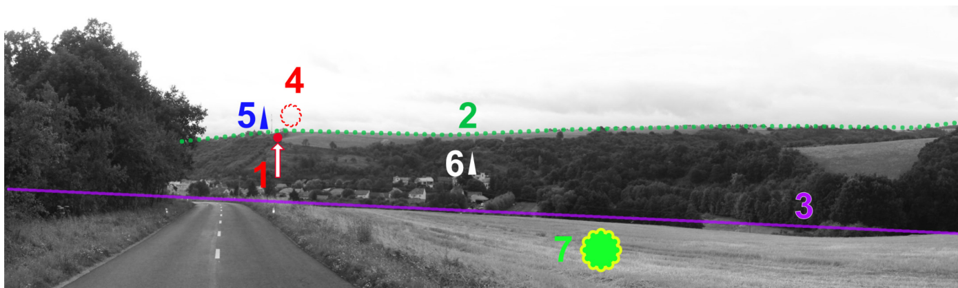
obr. č. 4 – krajinný prostor dotčený navrhovaným záměrem – okruh zřetelné viditelnosti 0,5 km od jihovýchodu, vizuální projev zájmového území (foto: autor)
