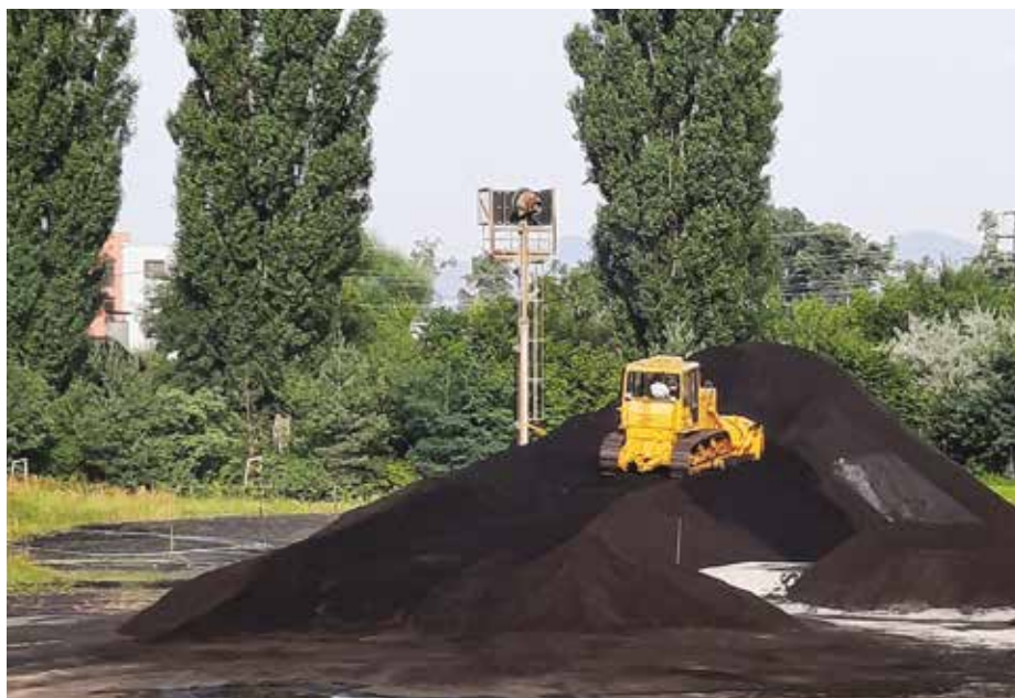
Odpad nebude skladován pod širým nebem, jako je to nyní u uhelného prachu, ale uvnitř zařízení.
