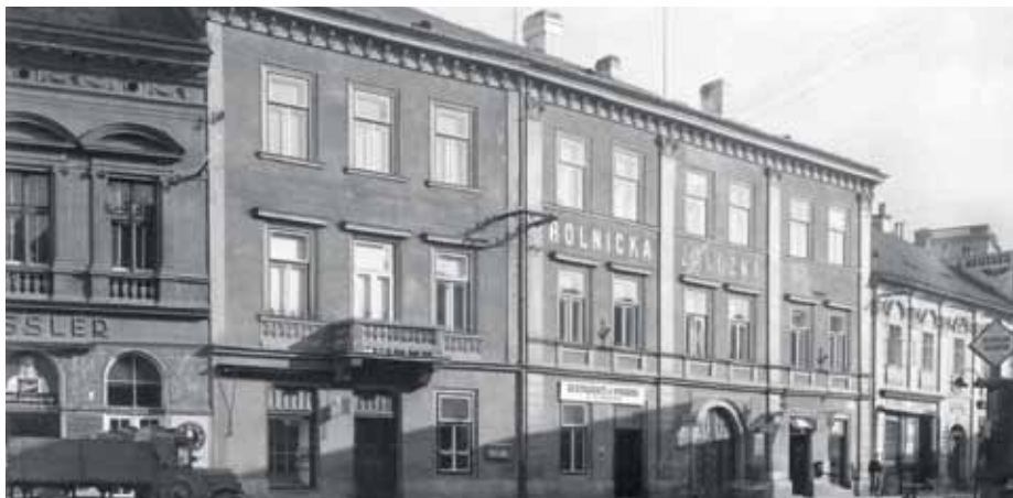
Sídlo Rolnické záložny v Havlíčkově ulici.
