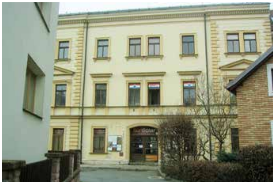
Pohled na dům č. p. 180 ze Sloupského ulice.
