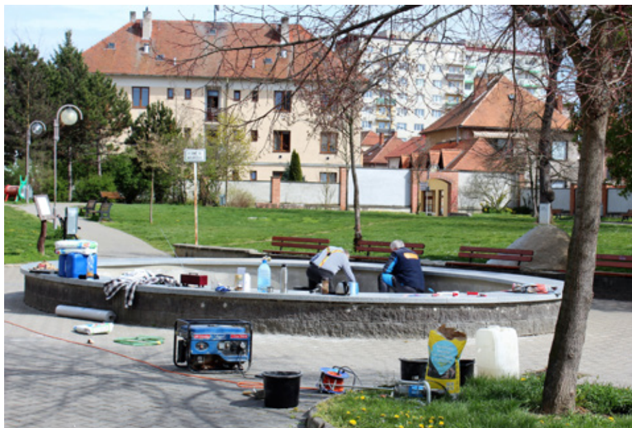
Oprava kašny v Bastionu.
