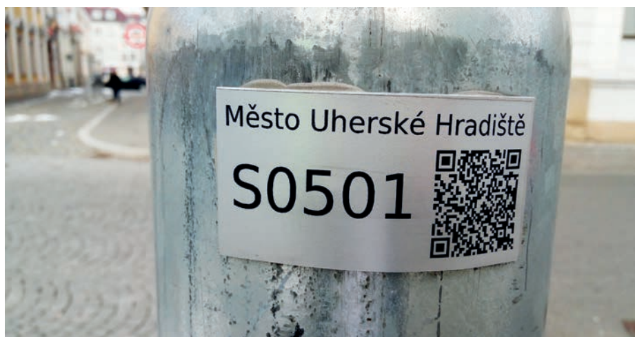
Sloupy veřejného osvětlení mají štítky s kódy, pomocí kterých můžete hlásit závady a poškození.
