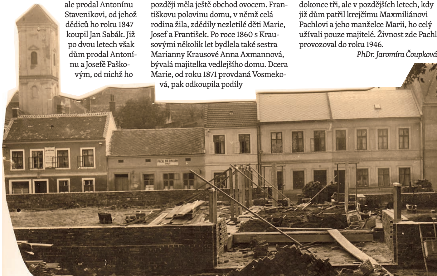
Pohled ze staveniště sokolovny na domy č. p. 115, 116, 215 a 117 v roce 1929.
