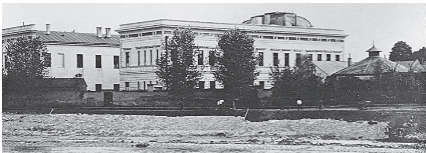
Pohled na budovy gymnázia z protějšího břehu Moravy, vpravo plynárna.
