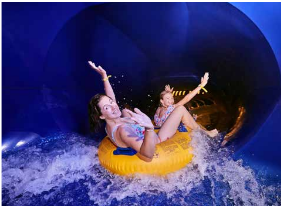
V hradištském Aquaparku skončila oprava tobogánových věží a v polovině května se mohli sklouznout první návštěvníci. Oprava začala v polovině ledna a zahrnovala kompletní výměnu vnitřních povrchů tobogánové věže, dojezdu tobogánu a technologií vzduchotechniky. Došlo také na nové LED osvětlení.
