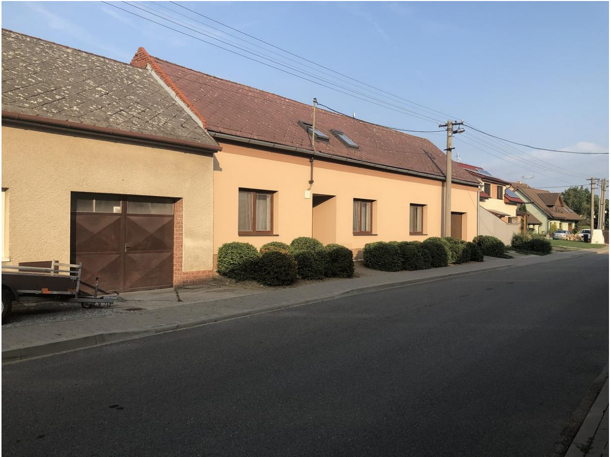
Řadová zástavba s okapovou orientací
