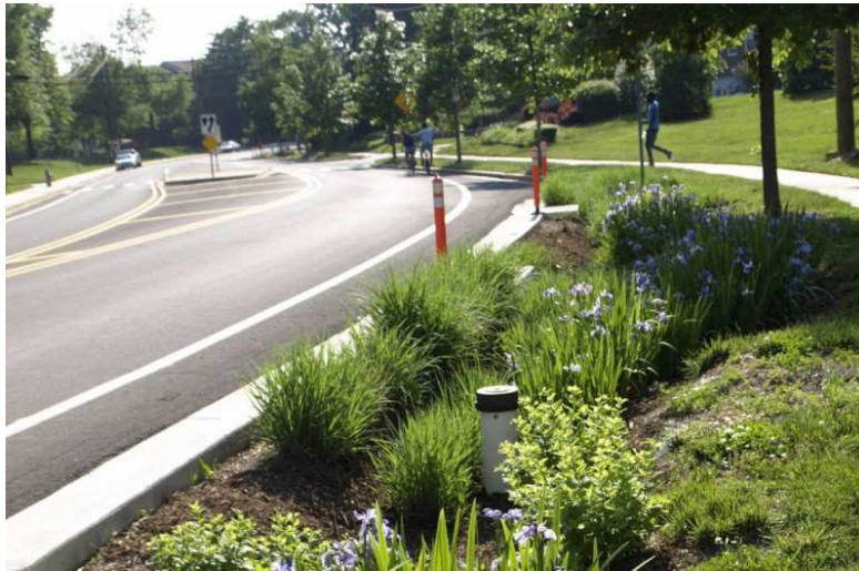
Zasakovací pásy zadržující vodu v území
