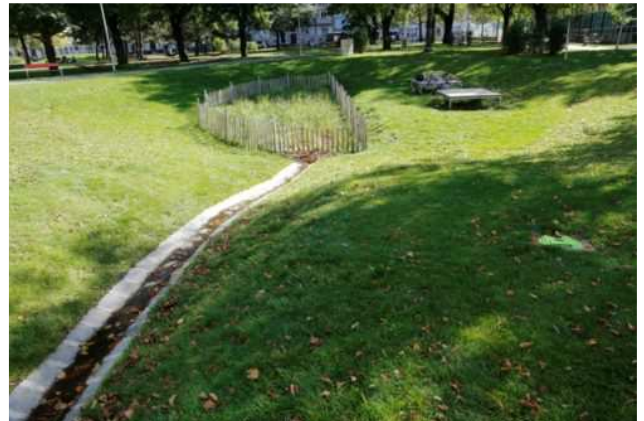
Kamenný vodní prvek v parku, odvod srážkových vod ze zpevněných ploch.
