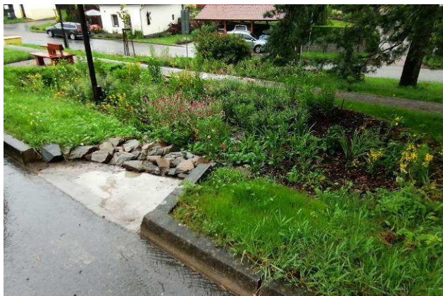
Odvod srážkových vod z komunikace. Kamenný drenážní zásyp.
