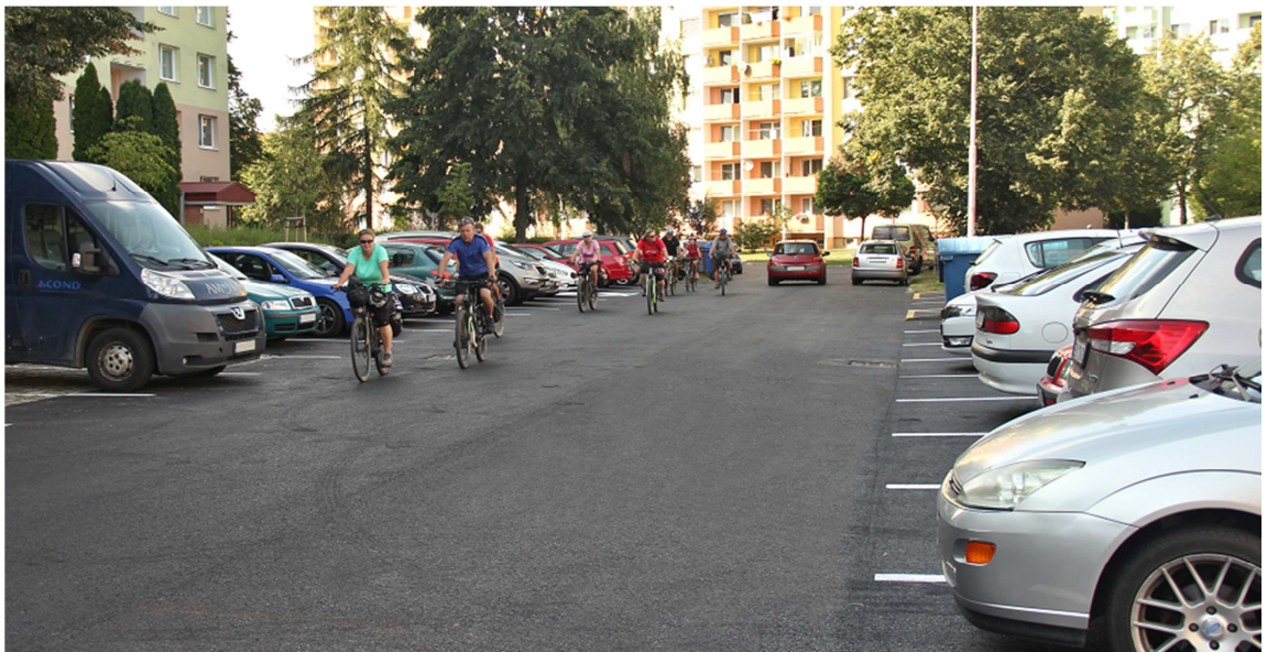
Velkoplošné opravy vozovek (Štěpnice – příjezd k domovu pro seniory)
