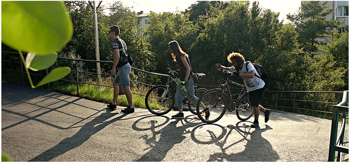
Oprava povrchu serpentín Mařatice II.etapa
