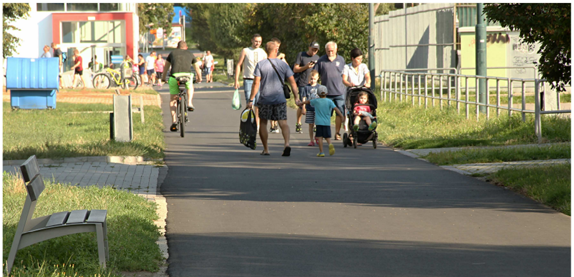
Plošná oprava ul. Sportovní (část podél ZŠ Sportovní)
