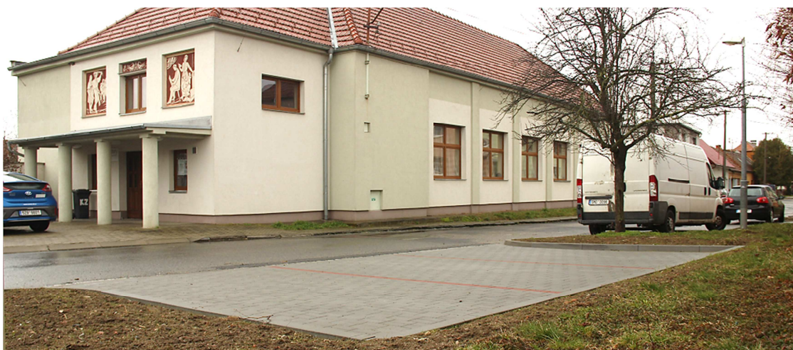
Úprava zpevněné plochy před MKZ ve Věskách (parkovací místa)
