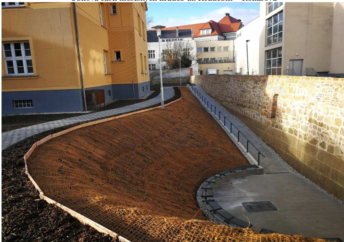
Obnova části městských hradeb ul. Hradební – Kollárova
