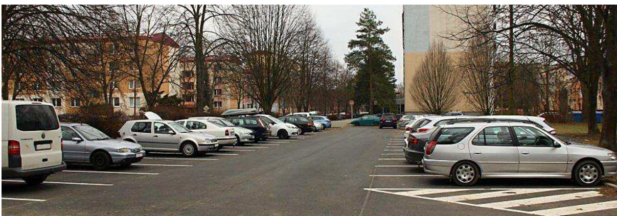
Rekonstrukce ul. Lechova (mezi ul. Rostislavova a 28.října), velkoplošné opravy vozovek (ul. Pplk. Štěrbý, ul. Na Stavidle, Pod Vinohrady, parkoviště ve Štěpnicích u BD čp. 1095)
