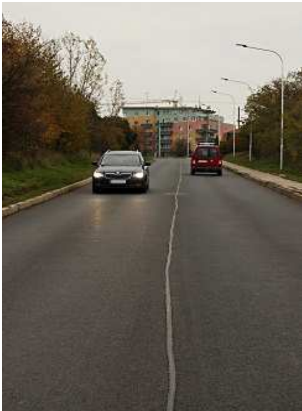
Velkoplošná oprava komunikace ul. Větrná
