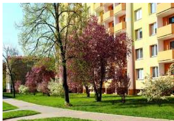
Revitalizace zeleně na sídlišti Štěpnice
