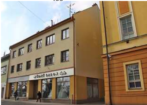
Oprava fasády na objektu Nádražní 24
