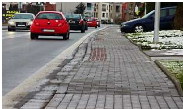
Vybudování nového chodníku, ul. Pivovarská
