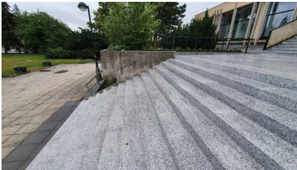
Kino Hvězda – oprava schodiště
