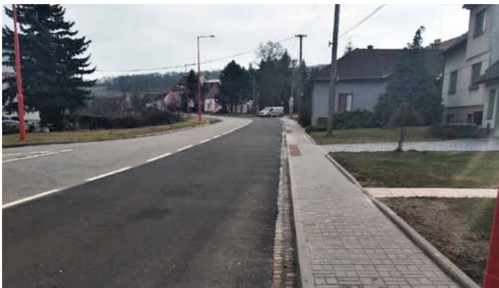
Oprava kanalizace Míkovice
