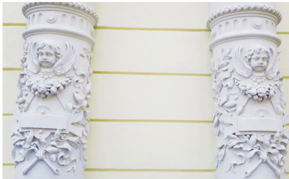
Komplexní obnova budovy radnice – MěÚ Uh. Hradiště
