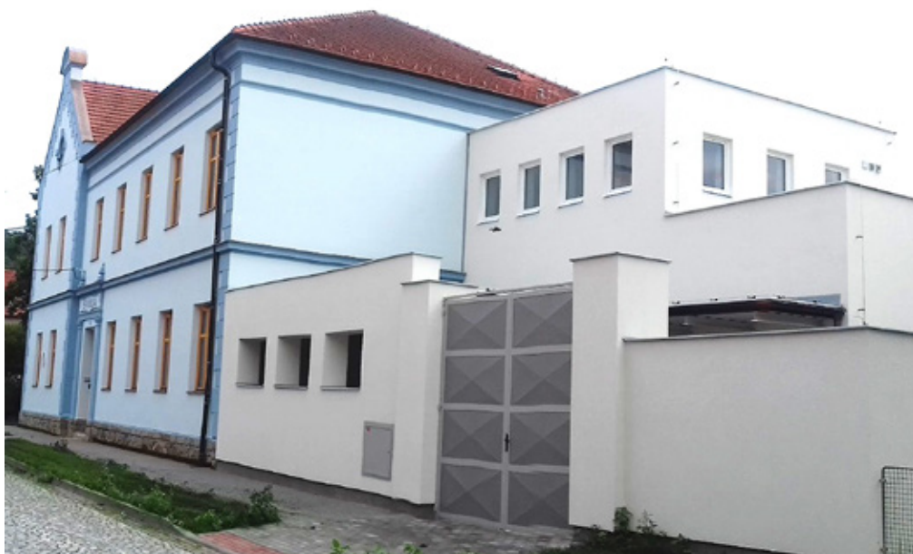
Rekonstrukce a přístavba MŠ Sady
