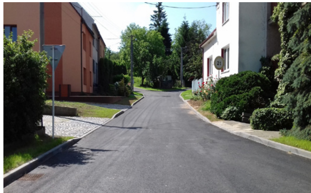
Odkanalizování ul. Před Branou, Jarošov
