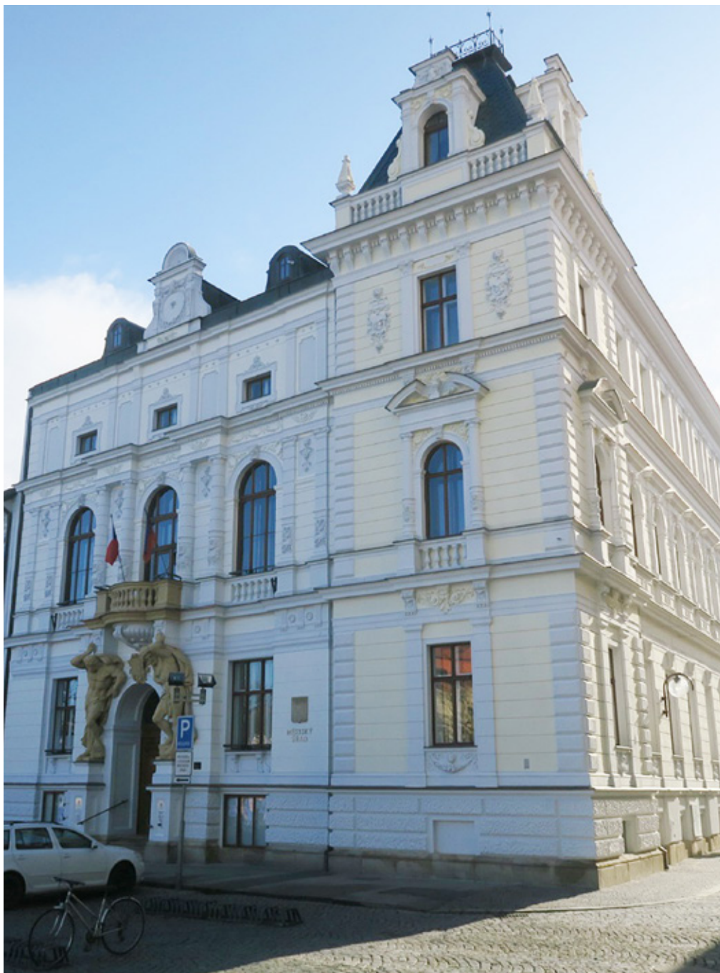
Komplexní obnova budovy radnice – MěÚ Uh. Hradiště
