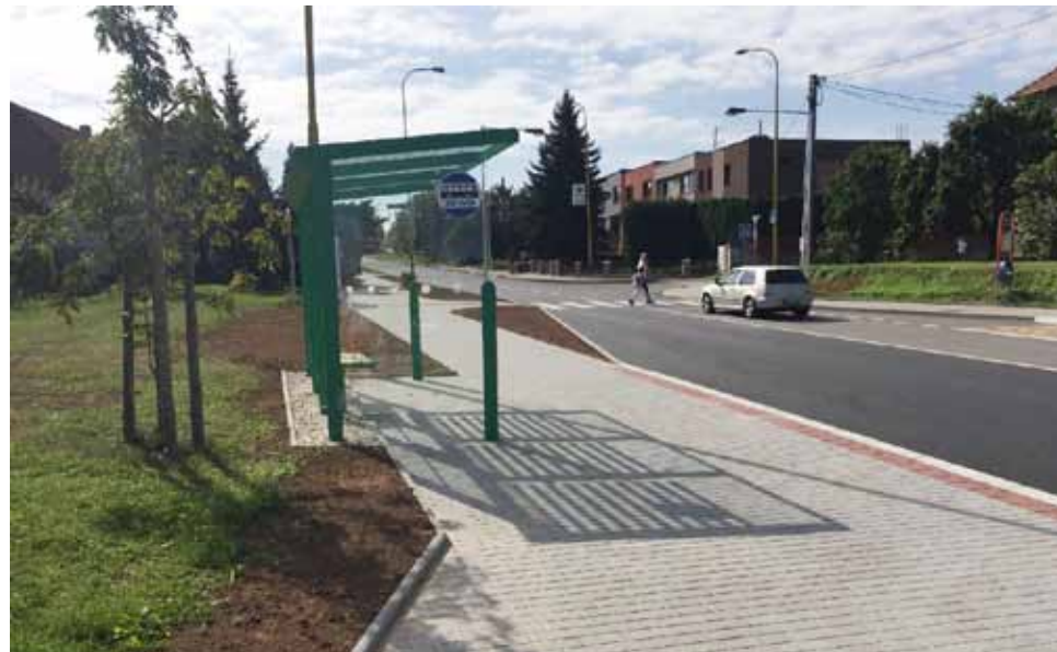
Rekonstrukce komunikace a chodníku ul. Sadová, Lomená
