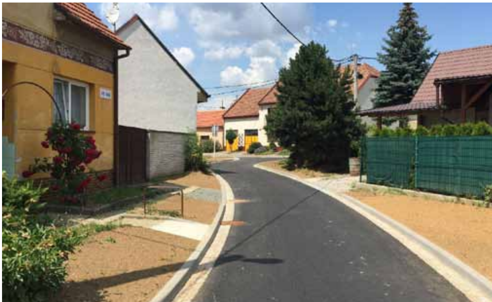
Rekonstrukce komunikace ul. Květinová, Věsky
