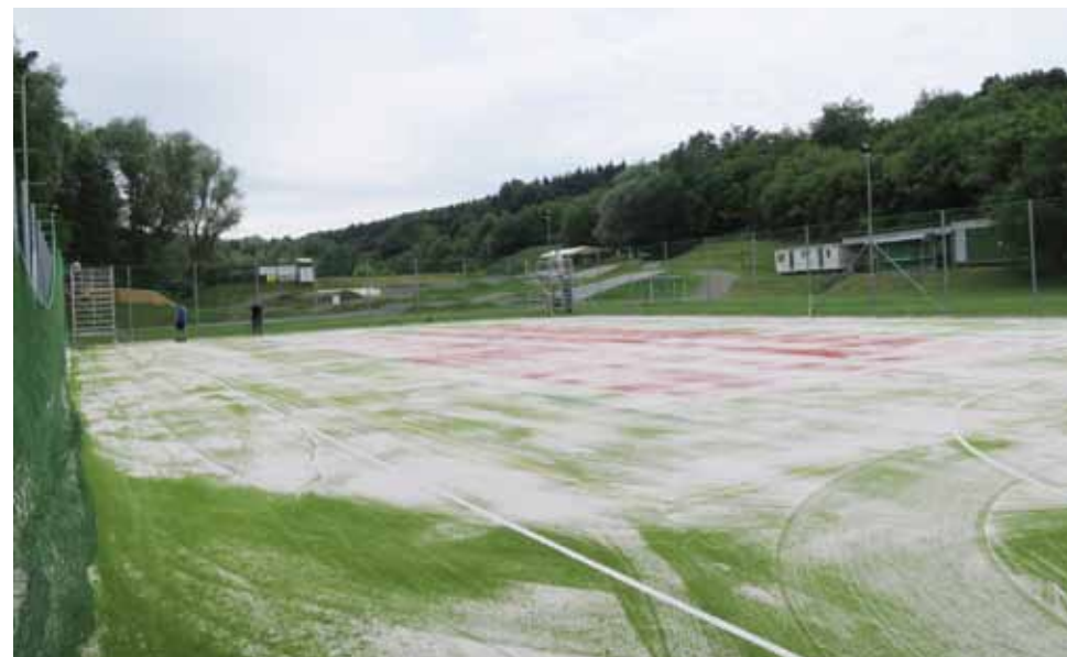
Výměna umělého trávníku na víceúčelovém hřišti v Míkovicích
