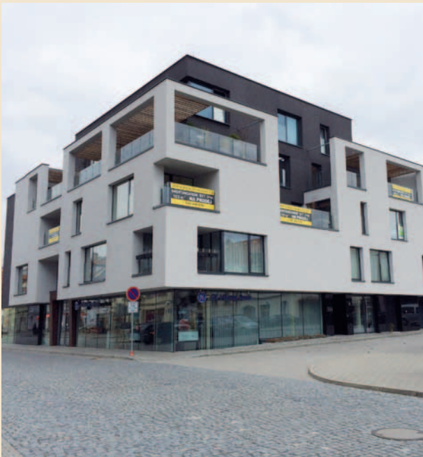
Novostavba polyfunkčního domu Galerie Zelný trh
